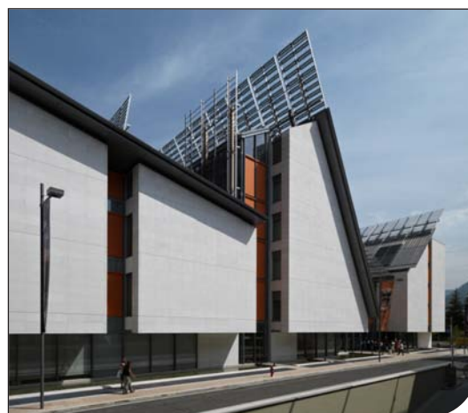
Fig. 7. Acclività delle falde e terminazioni con pannelli fotovoltaici. Steepness of the slopes and extremities with solar panels.
