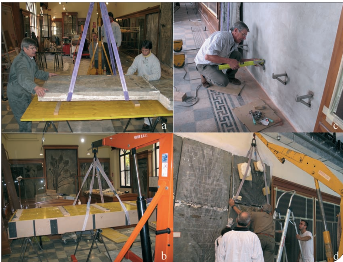
Fig. 7. Altre fasi dei lavori sulle grandi lastre della vetrina 156G; a sinistra in alto (a) le lastre vengono ricomposte su robuste basi di legno sostenute da cavalletti in acciaio, in basso a sinistra (b) realizzazione della cassamatta in legno riempita in schiuma poliuretana autoespandente, in alto a destra (c) posizionamento delle nuove zanche di acciaio inox, dopo il risanamento del muro, in basso a destra (d) ricollocazione delle lastre dopo la prima fase di restauro.
