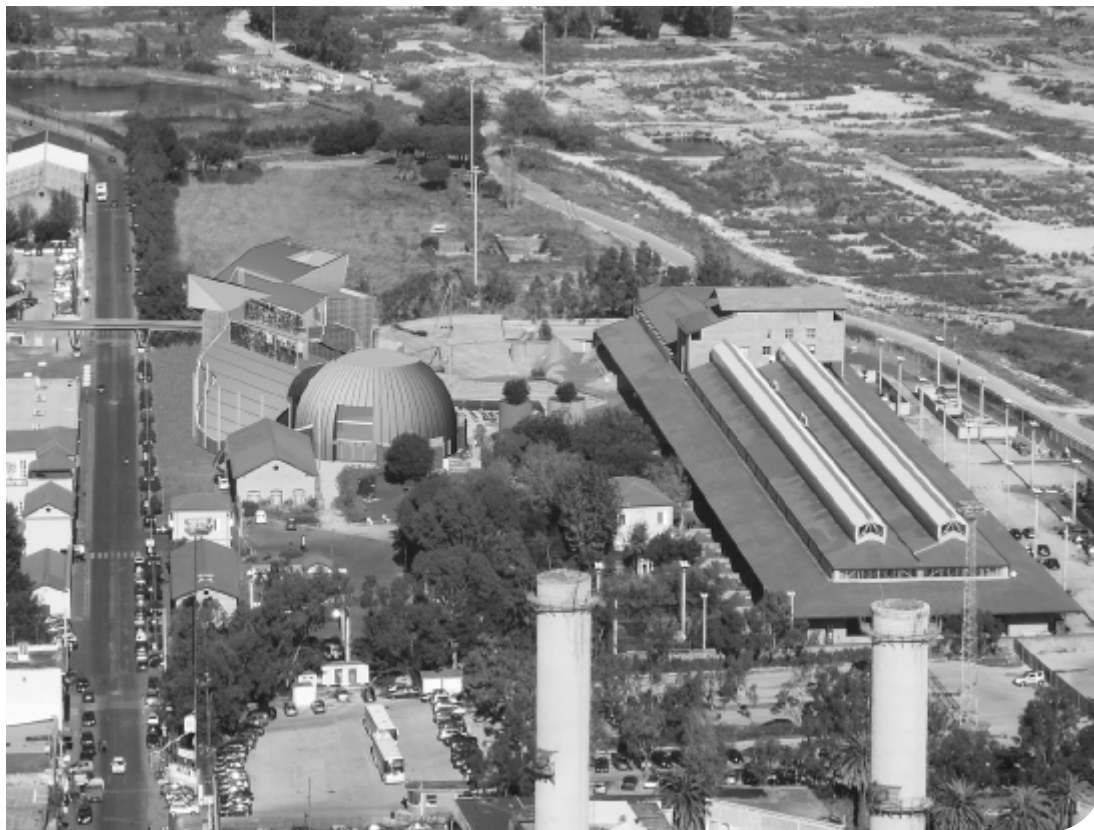
Fig. 1. Il nuovo edificio che ospiterà Corporea (vista aerea).
