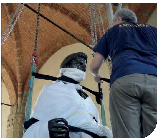
Fig. 2. Operazioni di sollevamento in sicurezza di una scultura bronzea.
