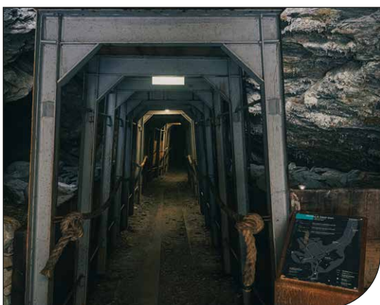
Fig. 6. Galleria di Saint-Jean dopo i lavori di messa in sicurezza (foto A. D'Aquila).
